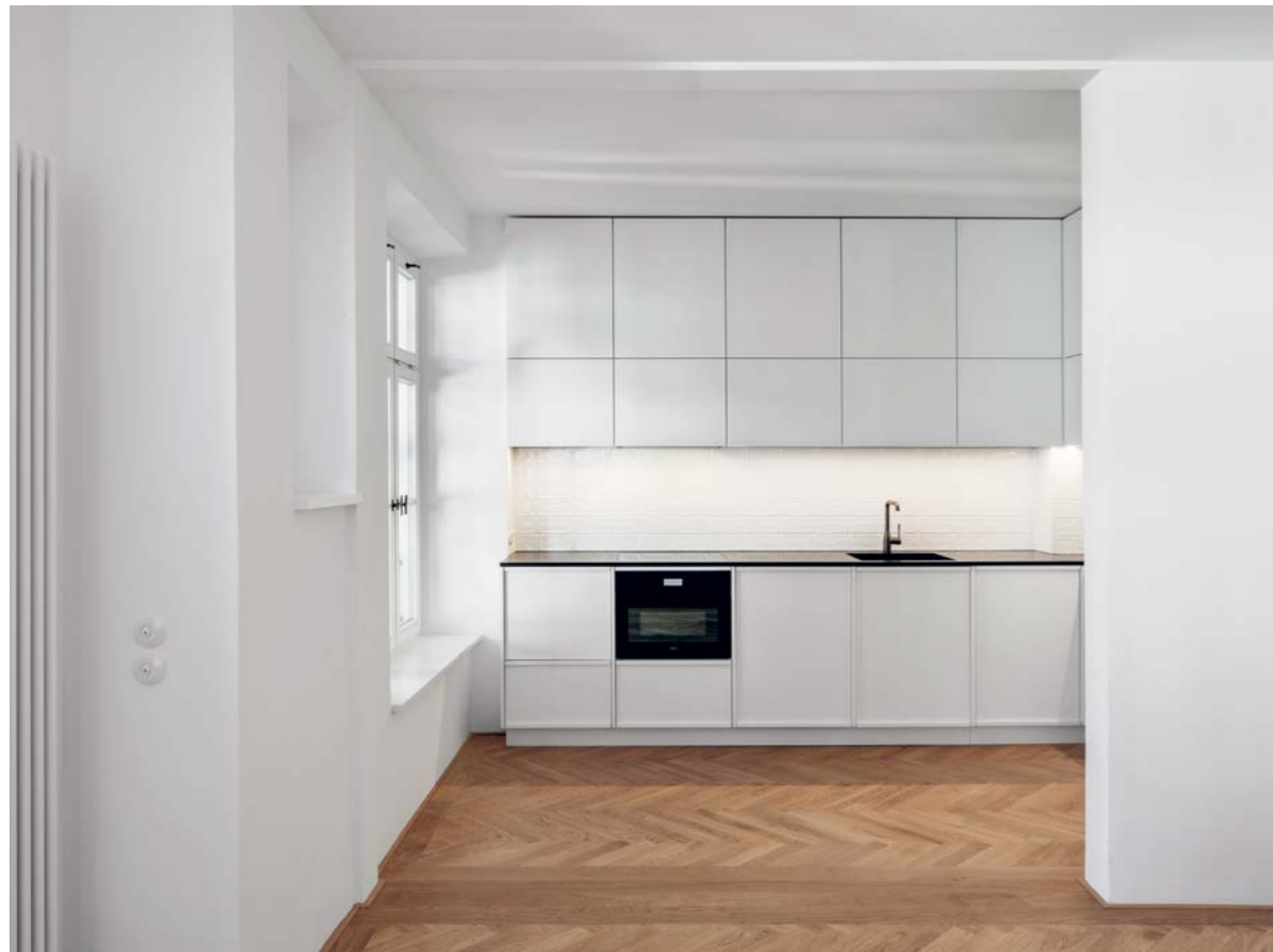
Küche und Innenausbau nach der Sanierung. 2022
