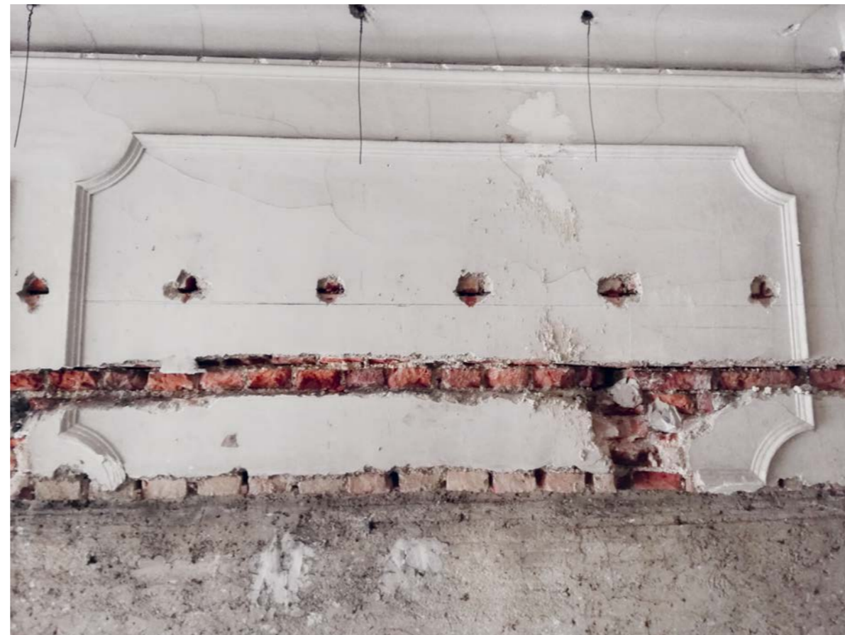
Bauzeitliche Stuckelemente (Fragmente) nach Freilegung 05/2021
