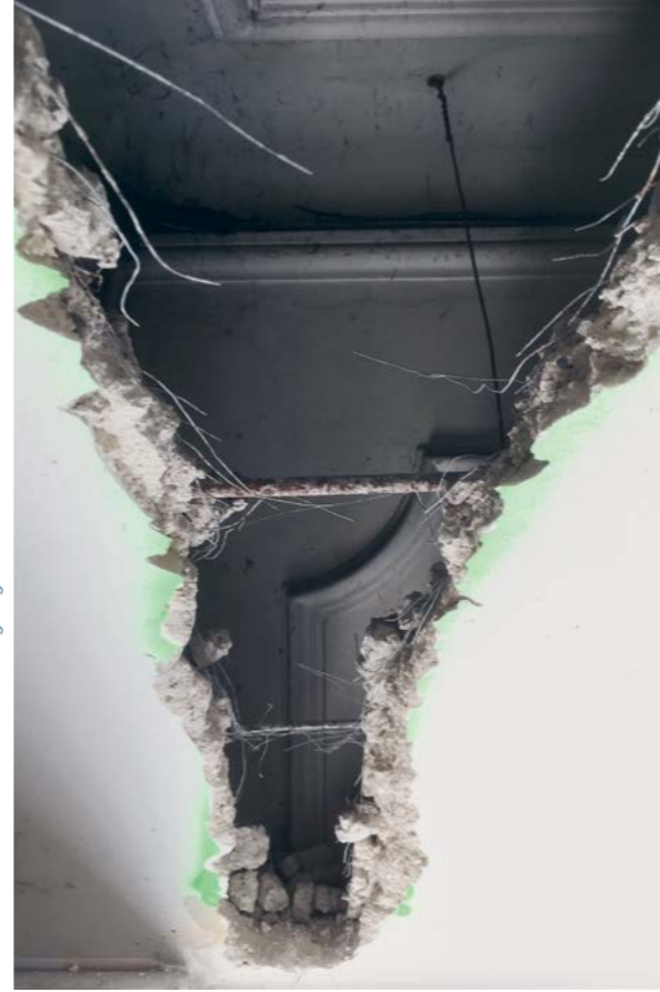
Durchfahrt nach Rückbau/Freilegung, 09/2020
