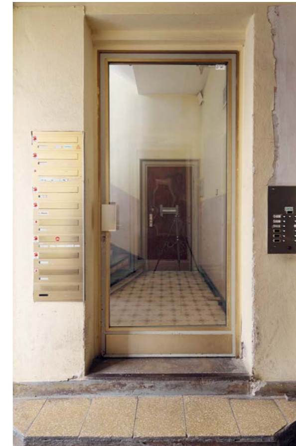
Abbildung links: Wohnungseingangstüre nach der Sanierung. 09/2023 Abbildung Mitte: Wohnungseingangstüre vor der Sanierung. Entfernen der Platten- beschichtungen. 05/2021 Abbildung rechts: Blick von der Durchfahrt auf den Hauseingang mit Briefkasten- anlage, vor der Sanierung. 2020
