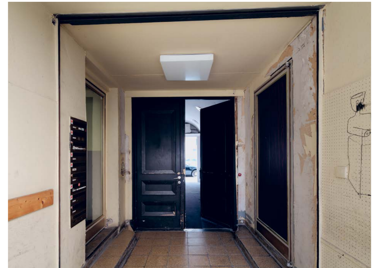
Durchfahrt (Hauseingang) Vor der Sanierung mit abgehängter Decke 08/2020
