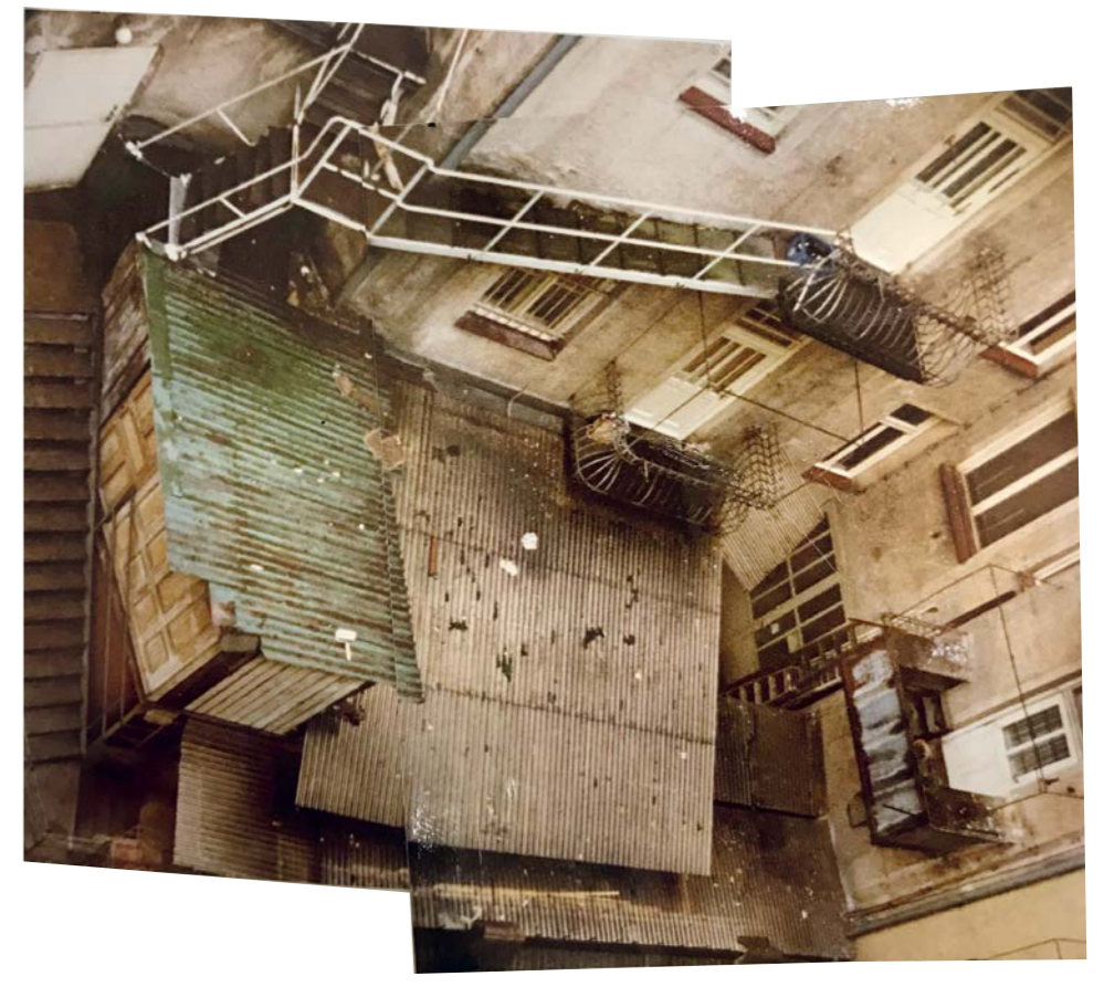
Verschläge errichtet aus bauzeitlichen Innentüren
