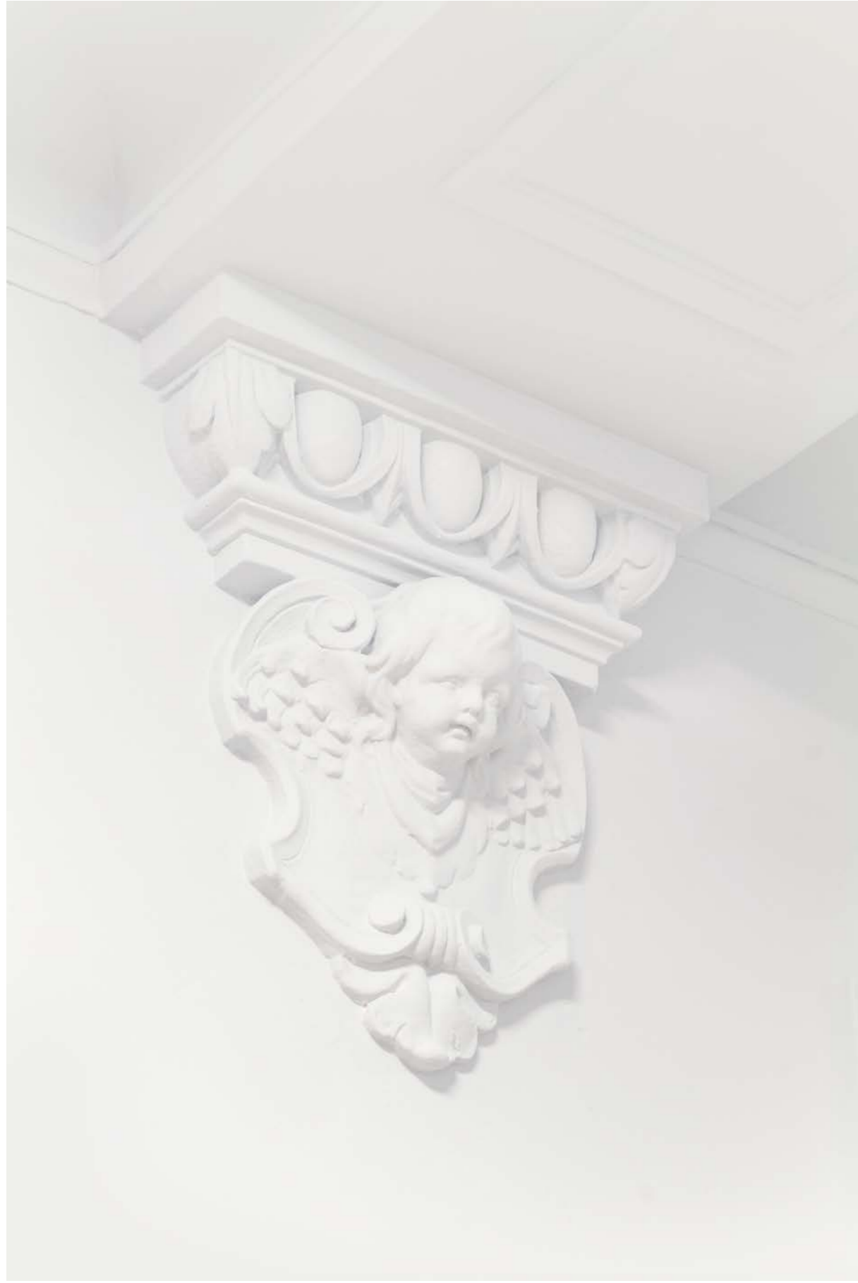
Bauzeitliche Stuckelemente in der Durchfahrt nach der Restaurierung, 04/2023
