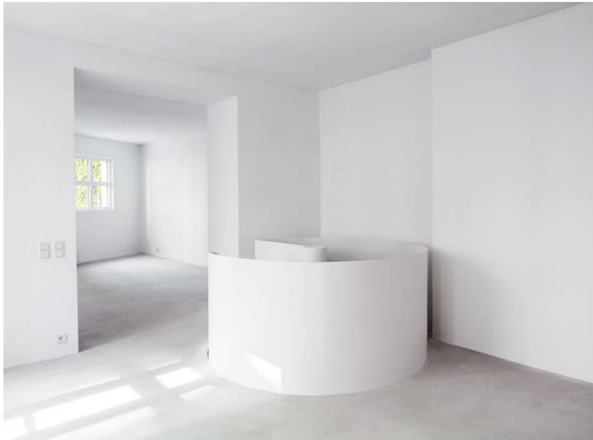
Abbildung links: Gewerbeeinheit im Erdgeschoss, Blick auf die neue Spindeltreppe zur Erschließung des umgenutz- ten Gewölbekellers. Nach der Sanierung (ohne Innenausbau). 06/2023
