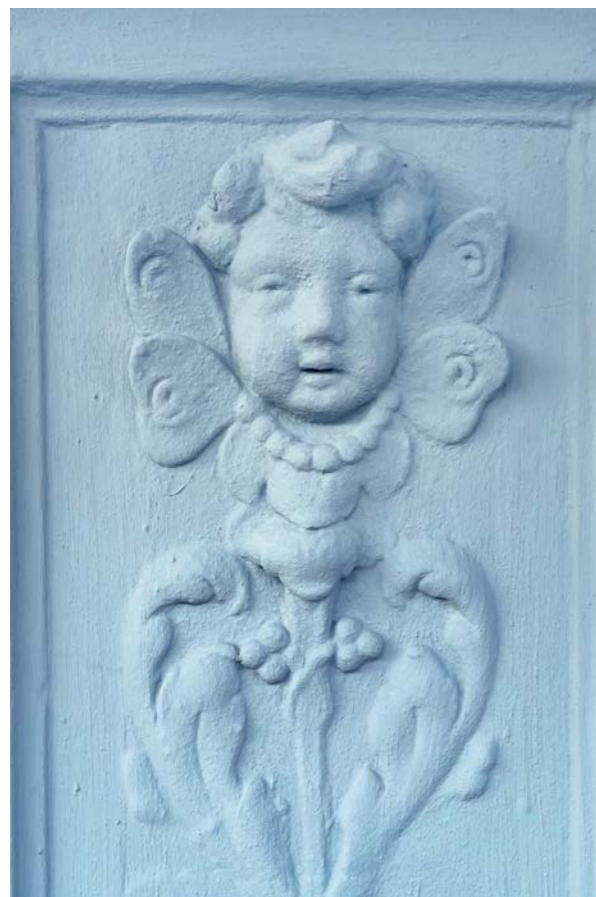
Bauzeitliches Detail an der Fassade. 11/2021
