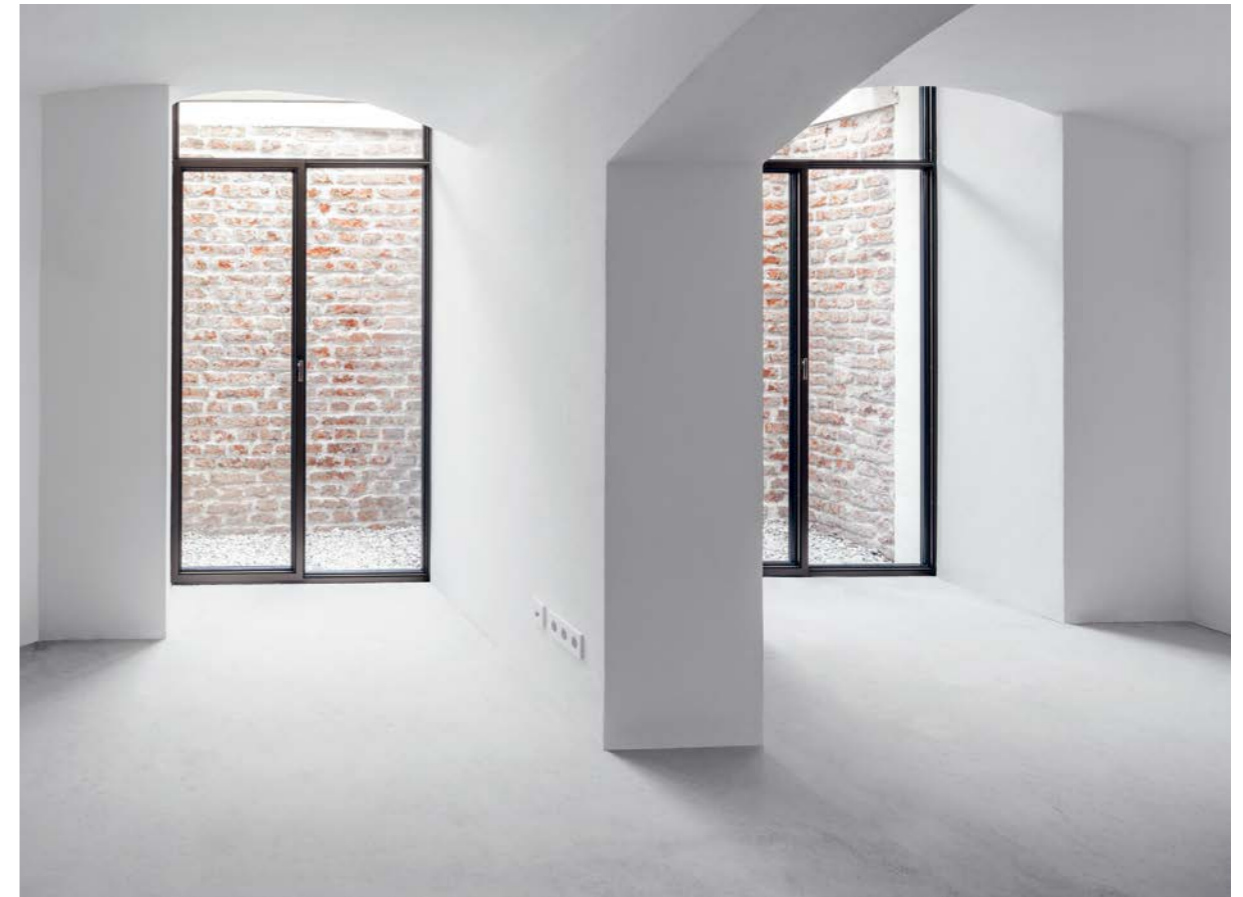
Abbildung rechts: Blick auf die beiden bauzeitlichen Lichtschächte im ehemals als Heizungsraum genutzten Gewölbe- keller. Nach der Sanierung (ohne Innenausbau). 06/2023
