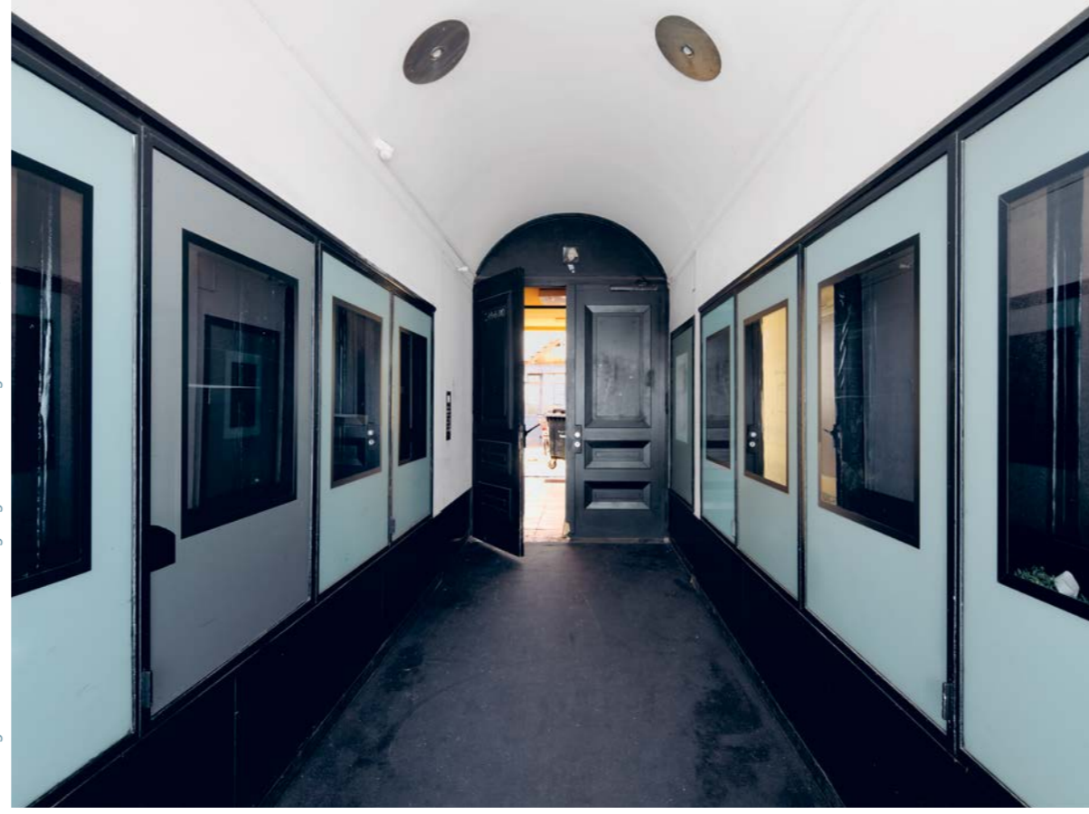
Tonnengewölbe laut Genehmigung Wollenschläger 1931, 08/2020
